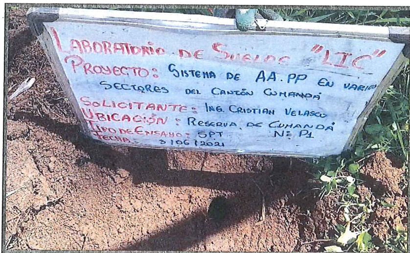
CALICATA PERFORACIÓN PUNTO P1
