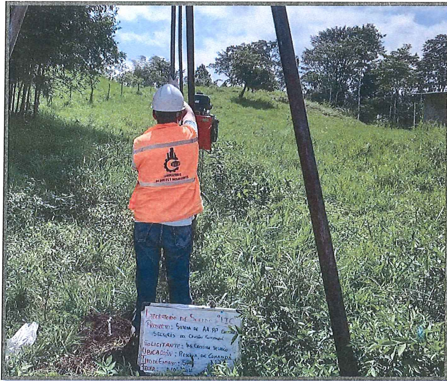
PERFORACIÓN PUNTO P1 PROFUNDIDAD 5.50 - 6.50 m
