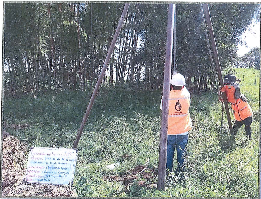
PERFORACIÓN PUNTO P2 PROFUNDIDAD 3.50 - 4.50 m
